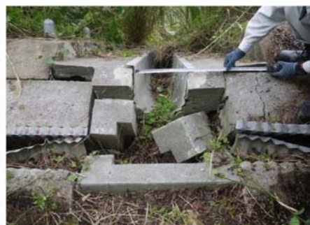
R1-Ph. ④ 法面上方からの圧縮破壊 集水枠のコンクリート柱が倒れる
