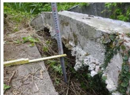
R1-Ph. ⑨ のり枠の滑落による沈下 40cm 変状の顕著な変化はみられない
