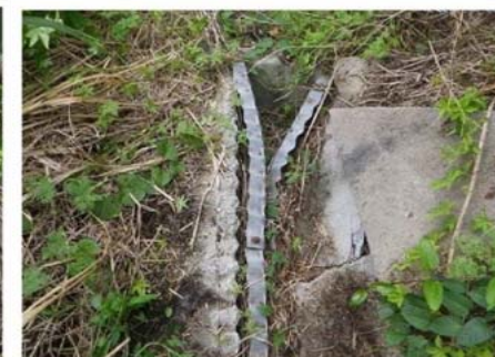
R1-Ph. ⑩ 排水溝の圧縮変形 B=0cm 変状が進行する
