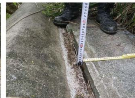
R1-Ph. ⑪ のり枠の滑落沈下 3.0cm 変状の顕著な変化はみられない
