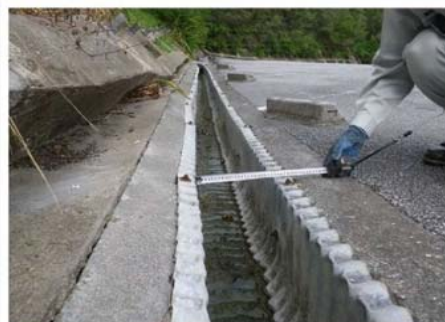
R1-Ph. ① 排水溝の圧縮変形 B=22cm 変状がやや進行する
