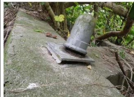
R1-Ph. ⑦ ロックボルト支圧盤の浮き上がり 変状の顕著な変化はみられない
