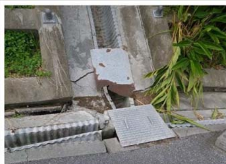
R1-Ph. ② 縦排水・集水枠、排水溝周辺 変形・損傷が進行
