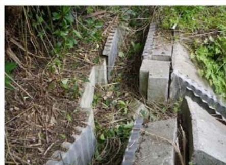
R1-Ph. ⑤ 集水枠の圧縮破壊 集水枠のコンクリート柱が倒れる
