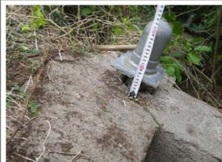
R1-Ph. ⑧ ロックボルト支圧盤の浮き上がり 変状の顕著な変化はみられない
