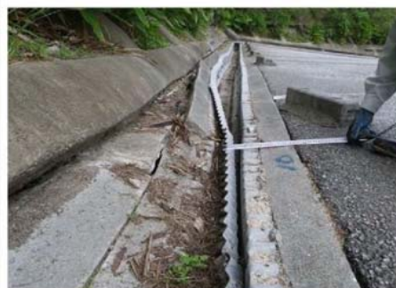
R1-Ph. ③ 排水溝の圧縮変形 B=8cm 変状が進行する
