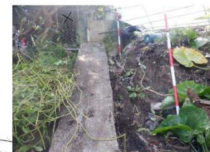
①起点側の状況、法枠のズレ
