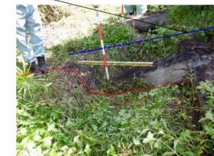
③法枠下部の状況、押出しによる隆起
