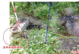
④ブロック境の状況 (左：法枠破壊、右：押出しによる隆起)
