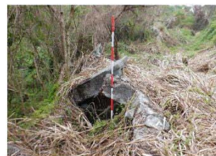
⑥斜面下部、法枠の圧縮破壊状況
