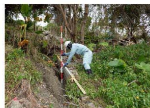
⑪終点側の被災状況（法枠側浸食）
