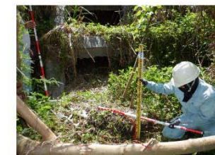
②法枠下部の状況、押出しによる隆起
