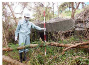
⑦法枠の圧縮破壊状況
