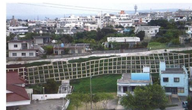
▲喜屋武急傾斜地(吹付枠工、鉄筋挿入工による整備)
