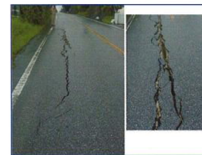
▲村道坂田線:6月10日9:30頃路面に亀裂が発生、11:00頃亀裂群が急速に拡大。
