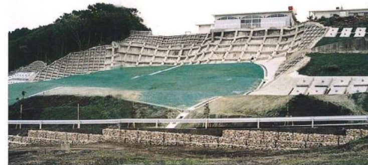
▲安里地すべり(アンカー付き法枠工による整備)
