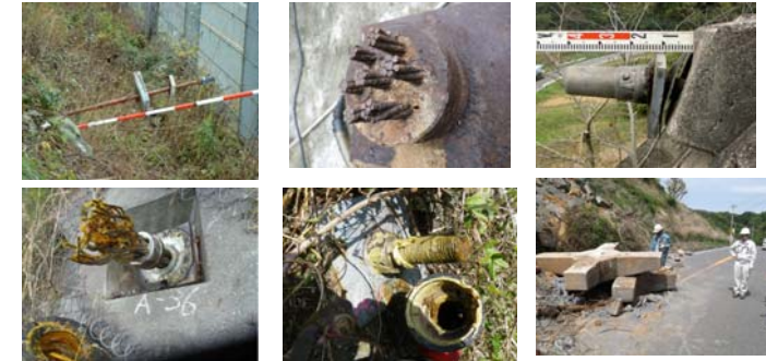
現場で見られる既設アンカーの変状事例
