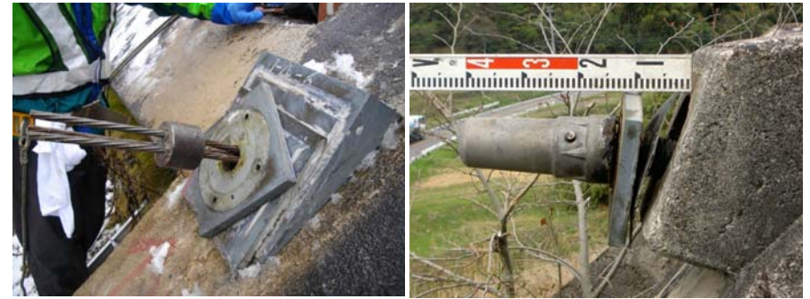
新タイプアンカーの定着部の引き抜けによる頭部の飛び出し
